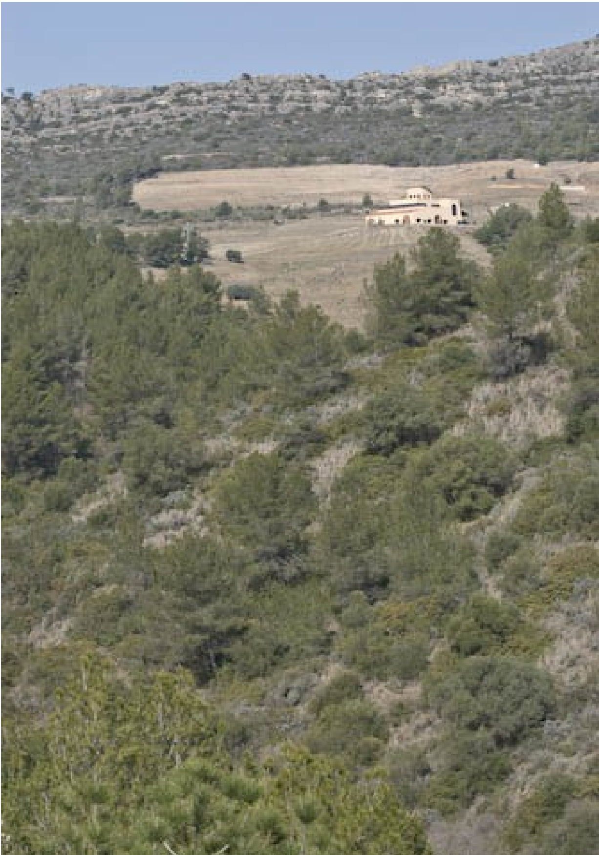
Vom Nachbarn Portal del Priorat kann man zum Keller von Cal Grau blicken.
