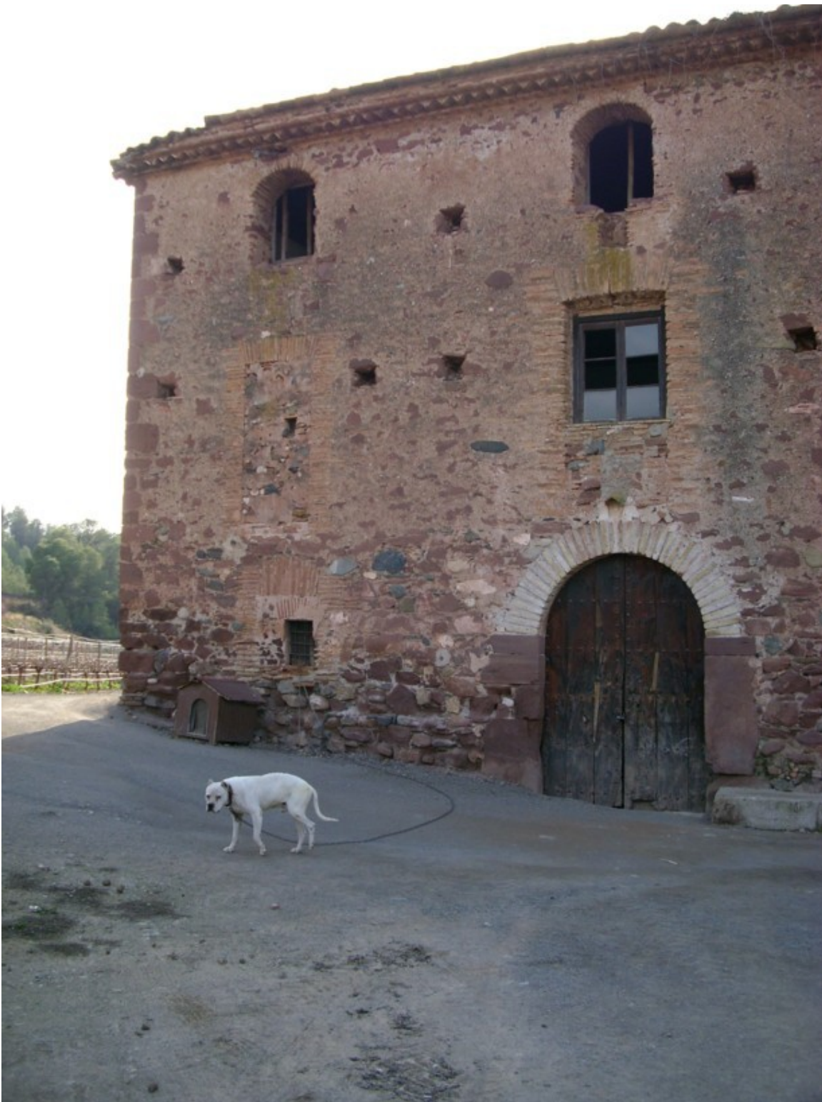
Das Haus, welches hier bewacht wird ist das Casa Gran im Siurana Tal. (TH) Gegenwärtig wird hier fleißig restauriert, aber auch interessante Weine werden hier bereits hergestellt.
