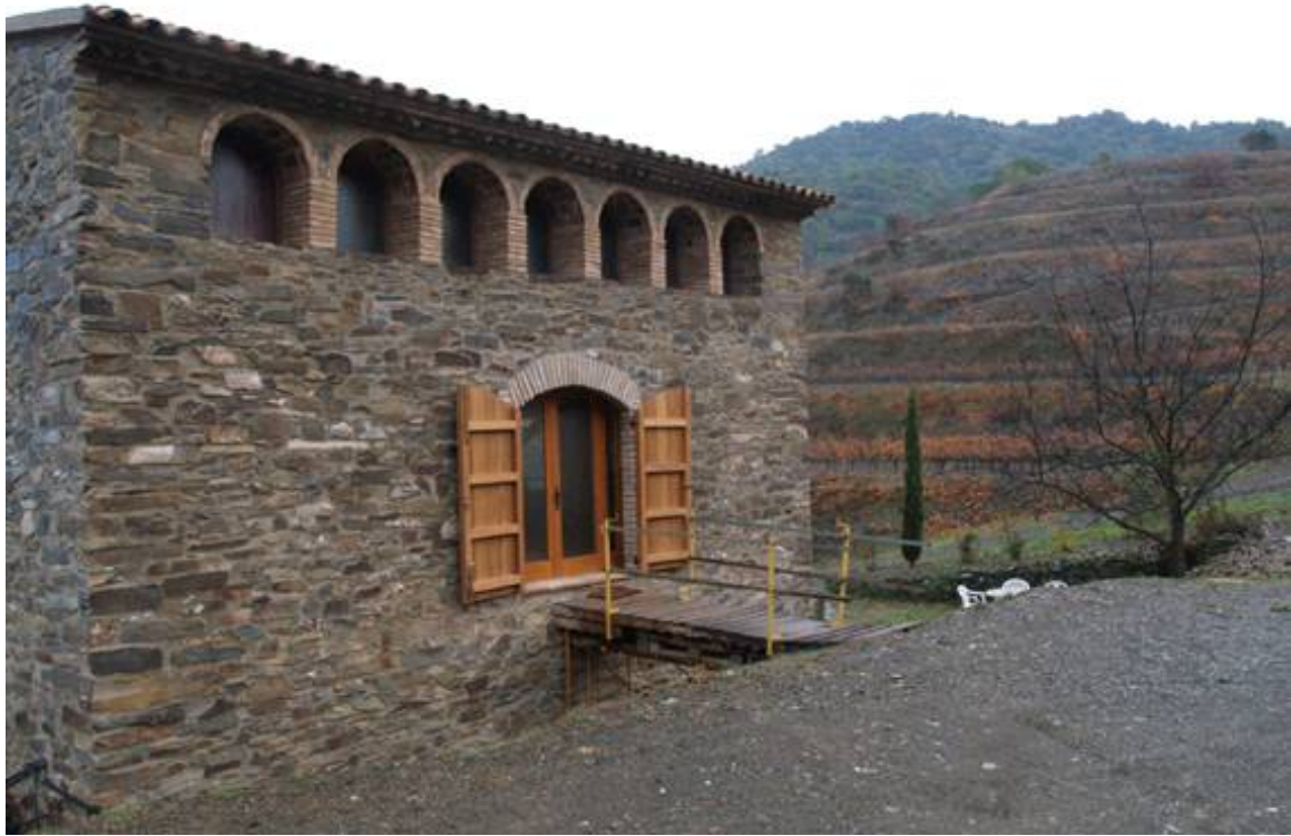
Das alte Mas wurde funktionell umgebaut, durch diesen Eingang werden die Trauben angeliefert. Im oberen Stockwerk sind Büro und Verkostungsraum. (MC)
